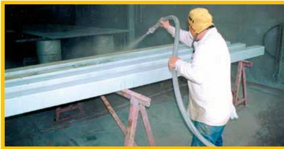
Figura 3. Procedimiento de chorro de arena (sandblasting) ligero
